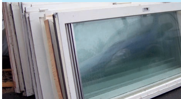
Zwischenlagerung von Altfenstern an der Baustelle zur späteren Wiedergewinnung von Wertstoffen
