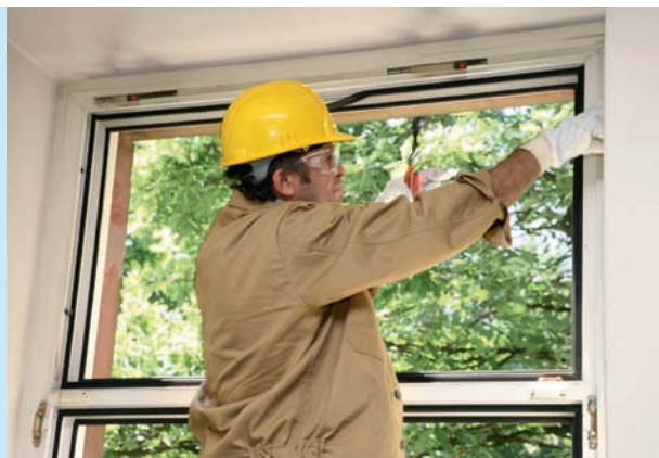
Mitarbeiter eines Abbruchunternehmens beim selektiven Rückbau von Altfenstern
